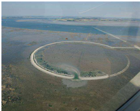
Innovatieve perskade rond de suppletie Galgeplaat.
